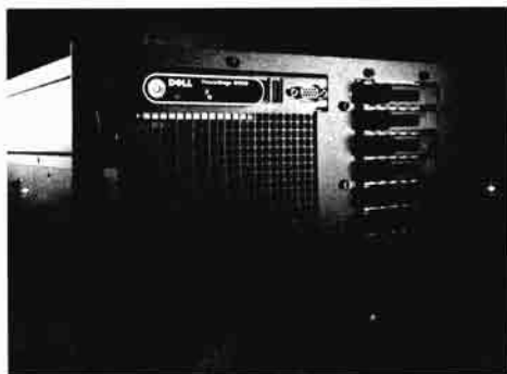
▲ 机房设备使用机架式服务器
