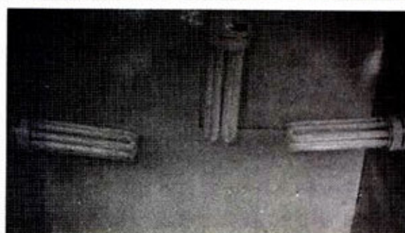
第二步: 在成型后的摄影棚内部粘满挂历纸,然后在顶部和左右两侧打孔,铁丝穿过小孔固定三盏照明灯并接入电线。
