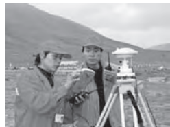
▲青藏铁路工程技术人员正在用GPS卫星定位技术测量保障施工,大大节省人的体力,在保证设计、施工勘测质量的前提下,保证勘测工作如期完成。
