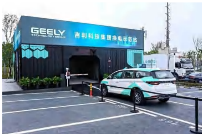
吉利科技集团换电示范站
