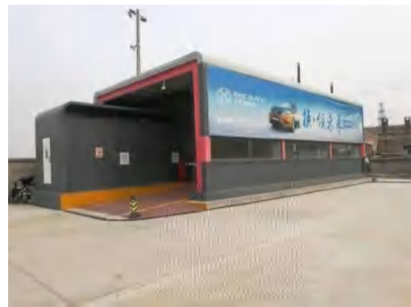
北汽新能源换电站
