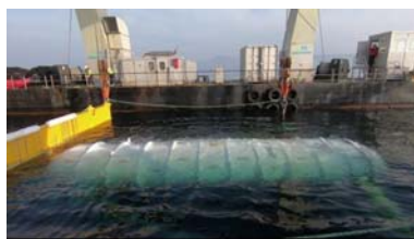
微软数据中心下海
