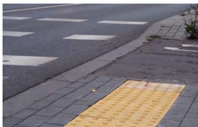
圆点形提示盲道能告知视觉障碍者前方路线的空间环境将发生变化
