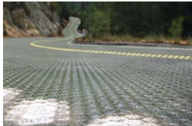
这条造价不菲的光伏公路位于美国66号公路密苏里段
