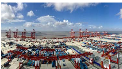
目前,洋山港四期配有10台桥吊、40台轨道吊、50台AGV
