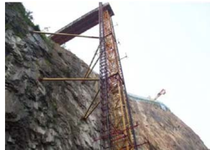
施工现场处处都是新奇的“发明”
