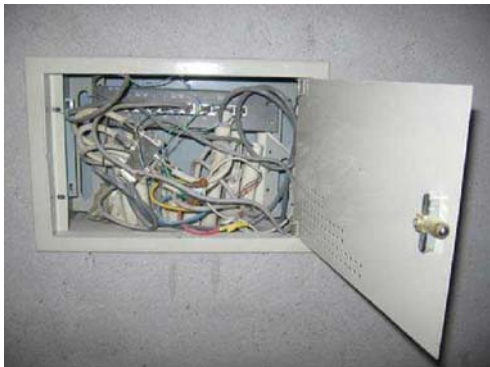
没有设置220V电源的弱电箱
