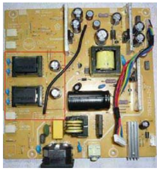
用电风吹吹背光升压部分,有利于解决问题
