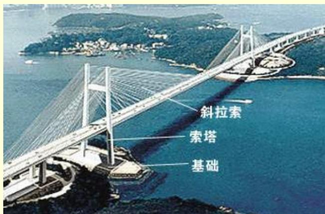
图 8.3 斜拉桥的结构
