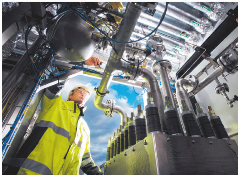
在德国汉堡，一位工程师正在检测输送可再生能源的管道。
