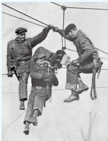
1915年,美国费城的工人们正在空中安装电线,这些电缆将为市郊通勤的火车供电。
