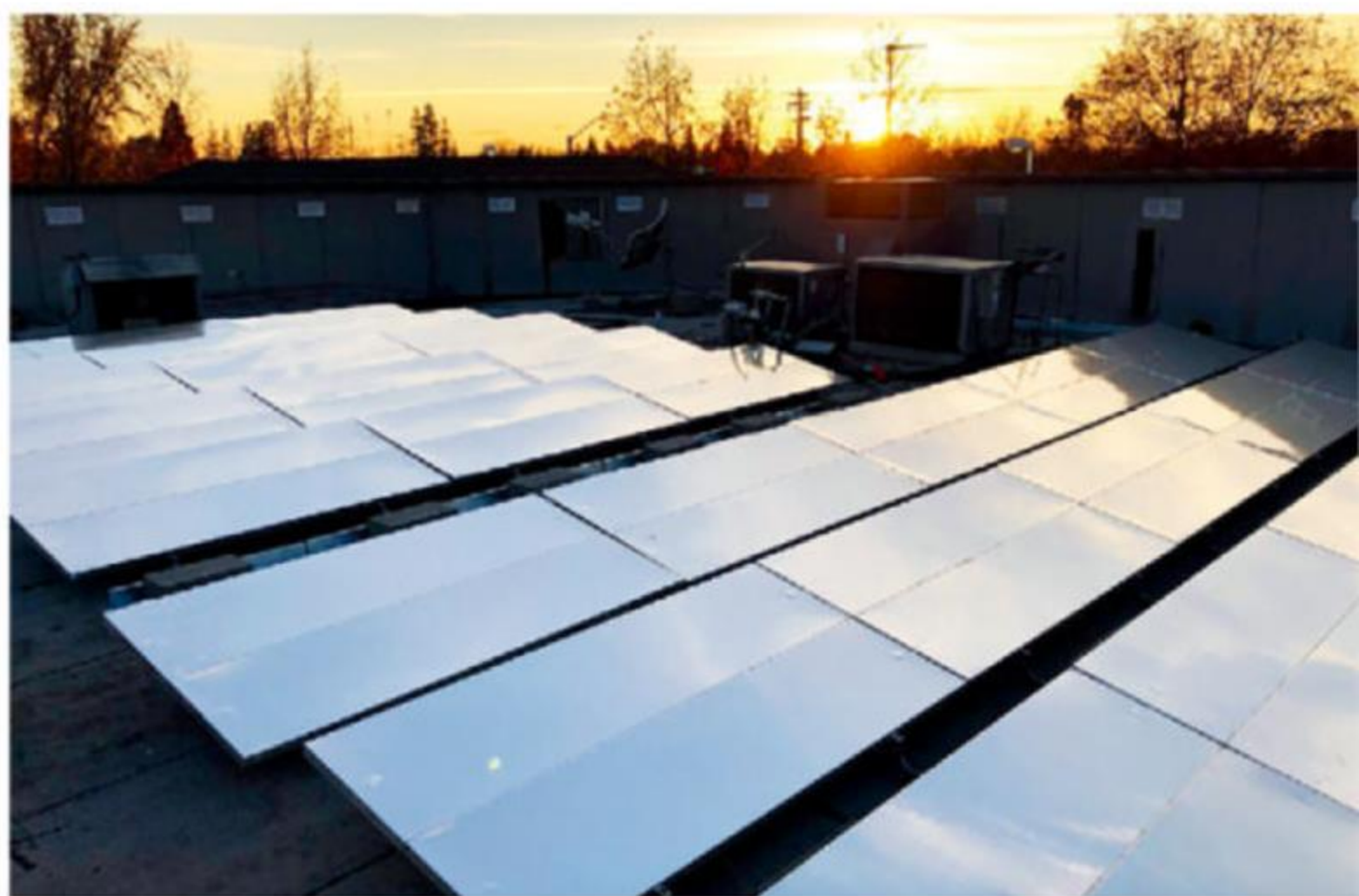
加利福尼亚州萨克拉门托一家商店的屋顶上安装了超冷面板。
