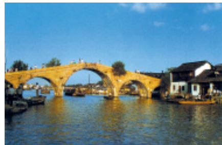
朱家角镇放生桥
