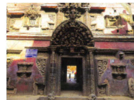
尼泊尔的古建筑中充满光与影的交换
