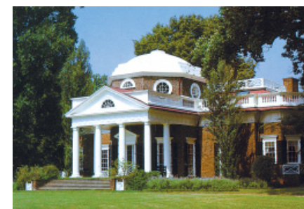
杰斐逊自己建造的房子
