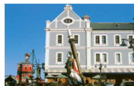
老港区船长的家是水门区内极为醒目的建筑
