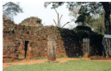
石砌古建筑遗址
