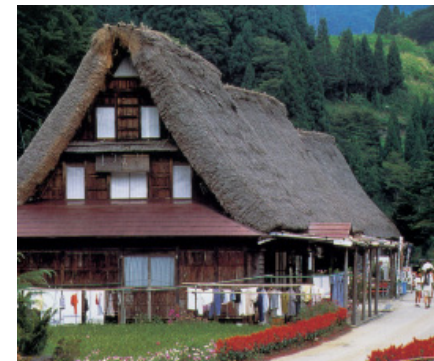
“人”字形木屋屋顶建筑
