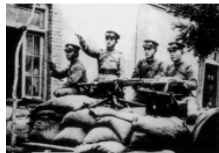
日军在济南城内修筑工事
