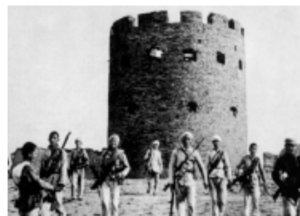
八路军武工队攻克曲阳县下河镇敌据点
