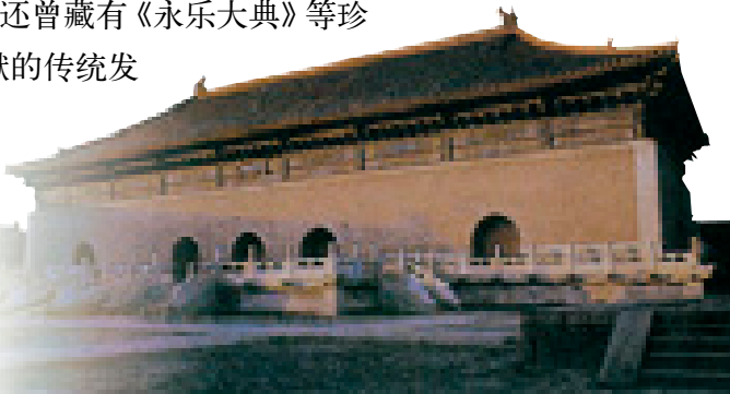
皇史宬外貌 整个建筑由皇史宬门、主殿、东西配殿和御碑亭组成，四周环以红色高墙。主殿为砖石仿木建筑。
