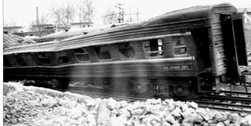
这条铁路线的受损状况，表明了唐山地震的破坏力。
