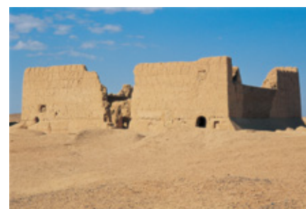
整座交河城在居民们的长期使用过程中有过不同程度的改建。每次改建都是继续向下深挖，所以民居墙壁上还保留着各个时期的挖凿痕迹。
