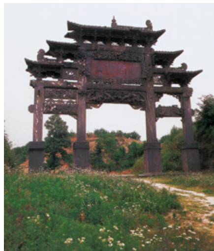
此门为玄岳门，为三间四柱五楼式的石建筑，建于明嘉靖三十一年(1552)，高12米，宽12.81米，石凿榫卯而成。
