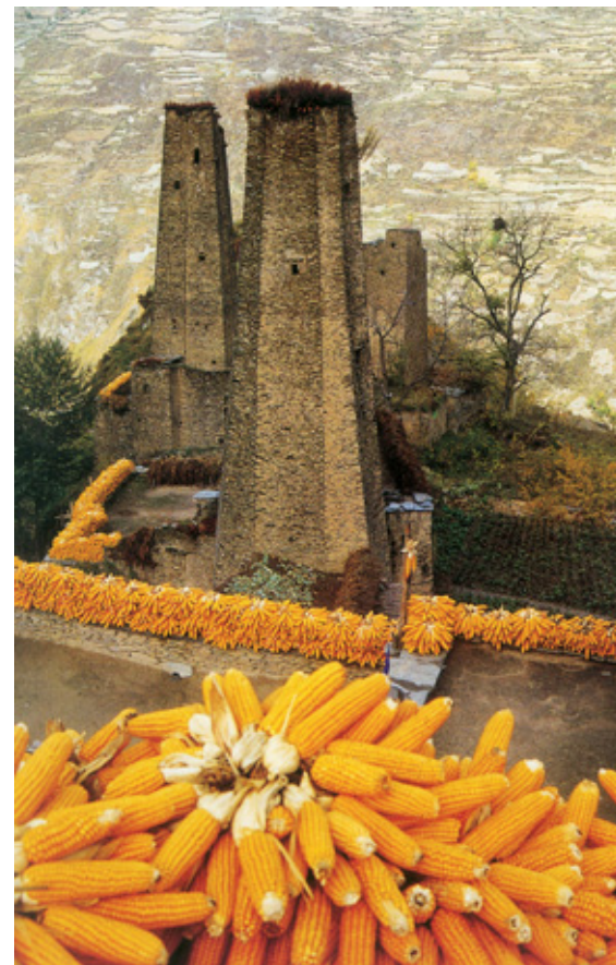
修建时无需吊墨打线，用黄泥和石块信手砌成就能经历数百上千年的风雨而不倒。
