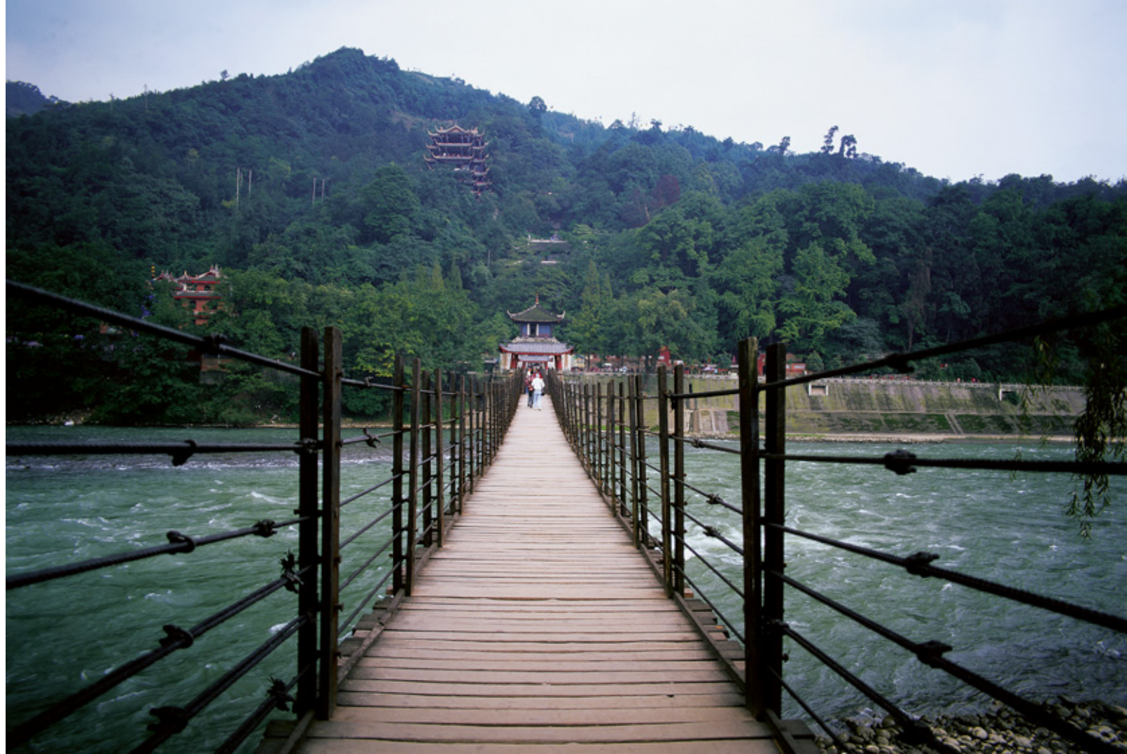
安澜索桥，建于都江堰岷江上，全长500余米，是我国西南山区常见的传统悬桥形式。
