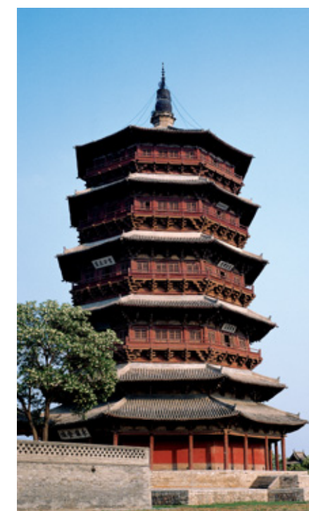
应县木塔为辽朝建筑，虽汲取唐朝风格，但还是有所发展。木塔塔身呈平面八角形，较之唐朝的方形平面更加稳定。
