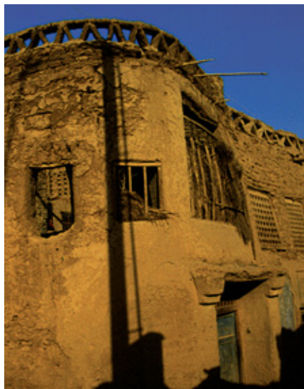
吐峪沟东西两岸山坡上现存的造型优美、鳞次栉比、绵延不断的古老民居，已有四五百年的历史，且无论是民宅还是千年前的佛窟，都是用黄黏土坯建造的。
