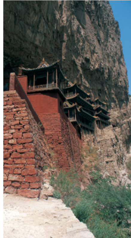
悬空寺为木质框架式结构，依照力学原理，半插横梁为基，巧借岩石暗托，梁柱上下一体。
