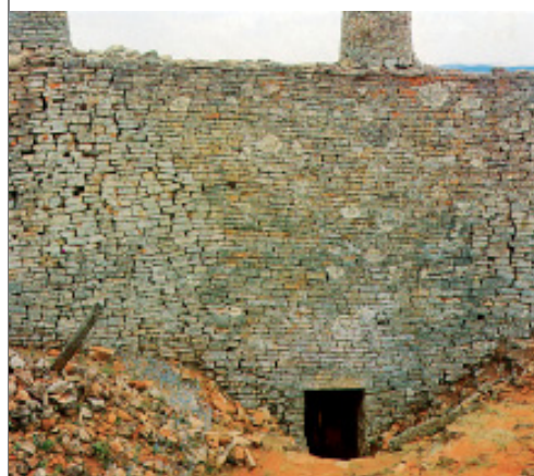
不用石灰，只靠砖砌石堆叠而成。竟能屹立数百年而不坍塌，实在令人难以相信。
