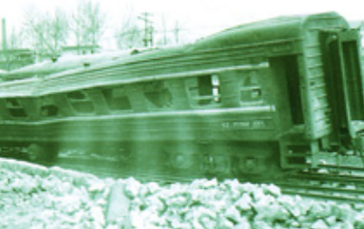
地震中受破坏的铁路线
