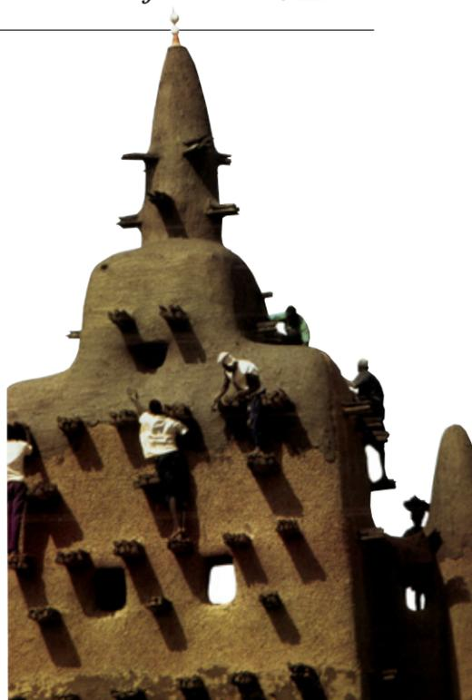
建筑工人正在往一座清真寺的墙上涂泥巴，对它进行修葺，墙上的脚手架就是这时候派上用场的。
