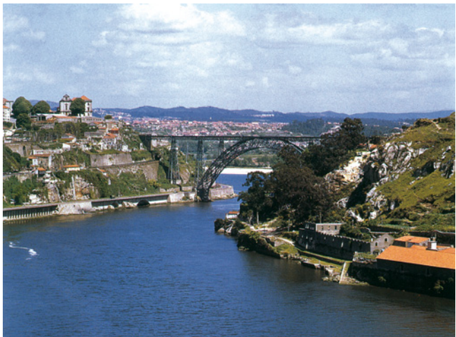
杜罗河上的路易一世桥
