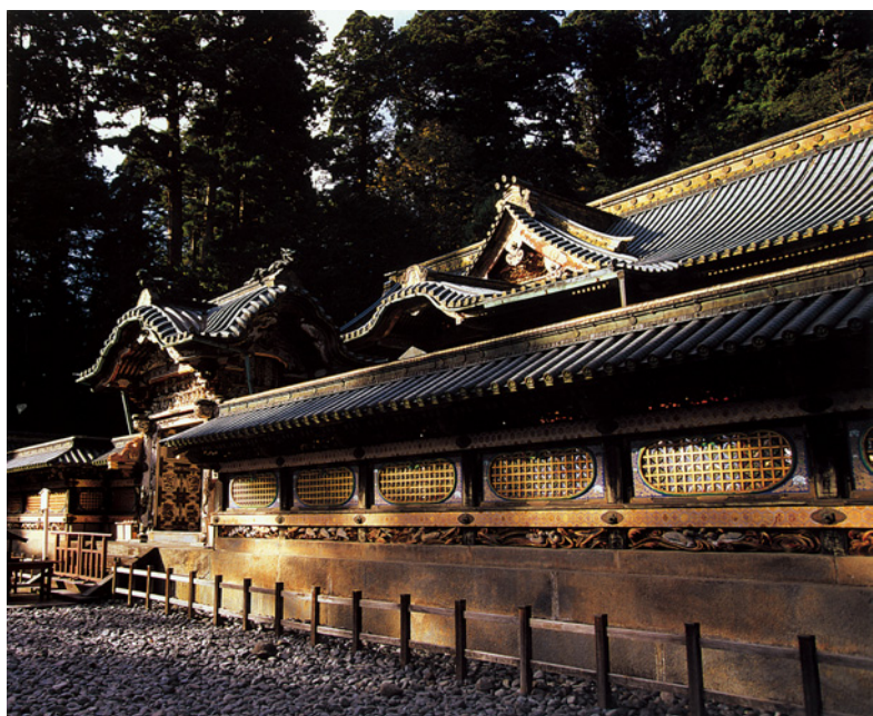
东照宫内古建筑
