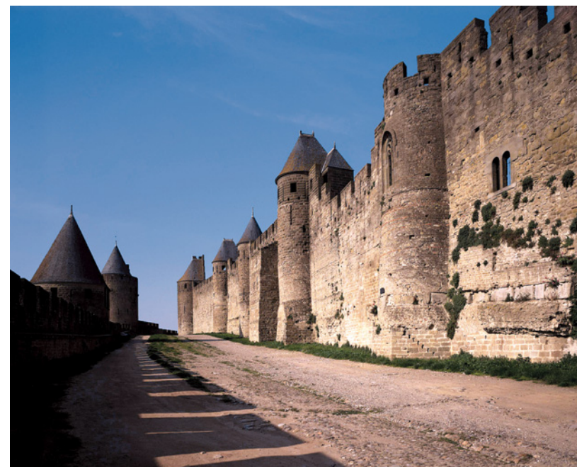
城堡中最为壮观的建筑景观莫过于保卫城堡的内外城墙与城塔。
