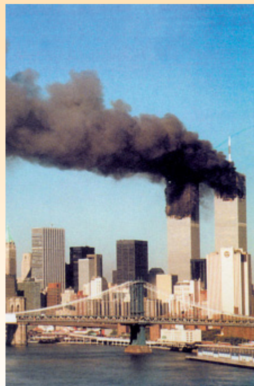
“9·11”事件中被炸毁的世贸大楼
