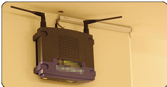
●把路由器安装在墙上
