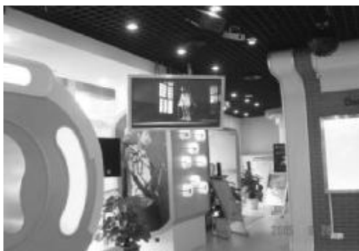
某展示厅吊装平板电视
