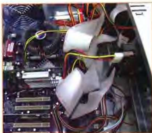
机箱内凌乱的信号线、数据线、电源线。
