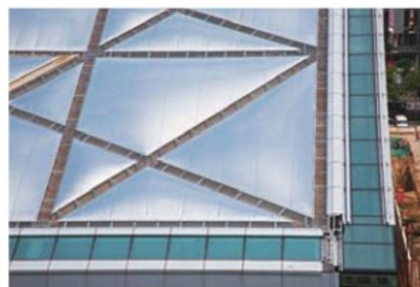
连接外罩的排水槽结构
