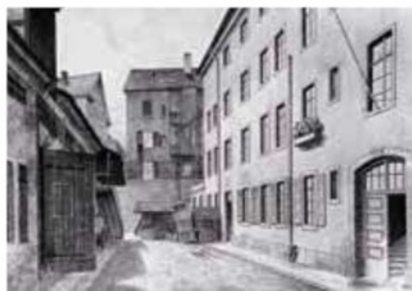
精密机械和电气工程车间，1886年
