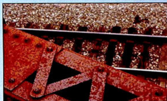
暴露在空气中的钢很容易生锈
