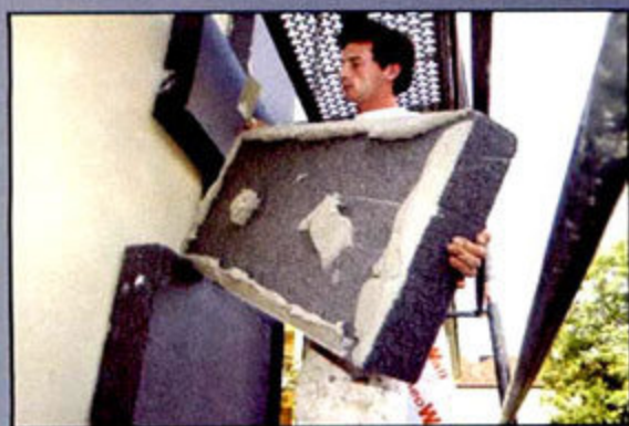
塑料用到墙体内部可以起到保温的作用。
