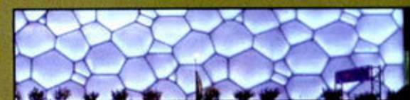
ETFE的使用寿命长达25年。
