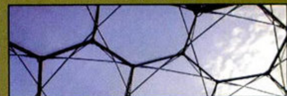
ETFE作为建筑材料的优势就在于它透光，隔热，隔音。
