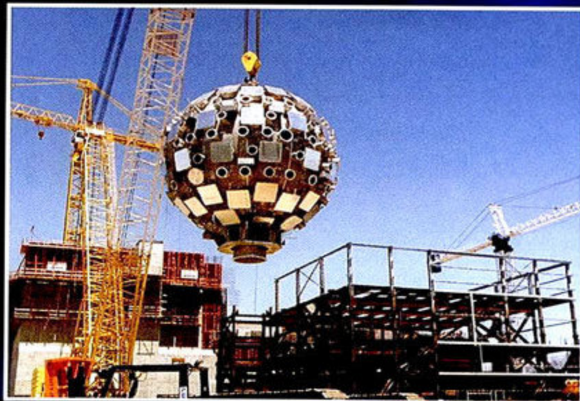
1999年6月，NIF开始安装直径9.75米的靶室。这个圆圆的真空容器由18个四英寸厚的铝制造组装，重量超过130吨。
