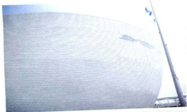
① 芬兰馆中的白色外墙采用了一种新型纸型复合材料
