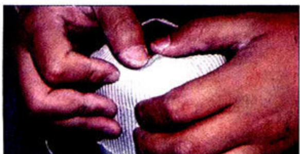
③ “大炮”在安装前需套上保温棉以及起防水棉布
