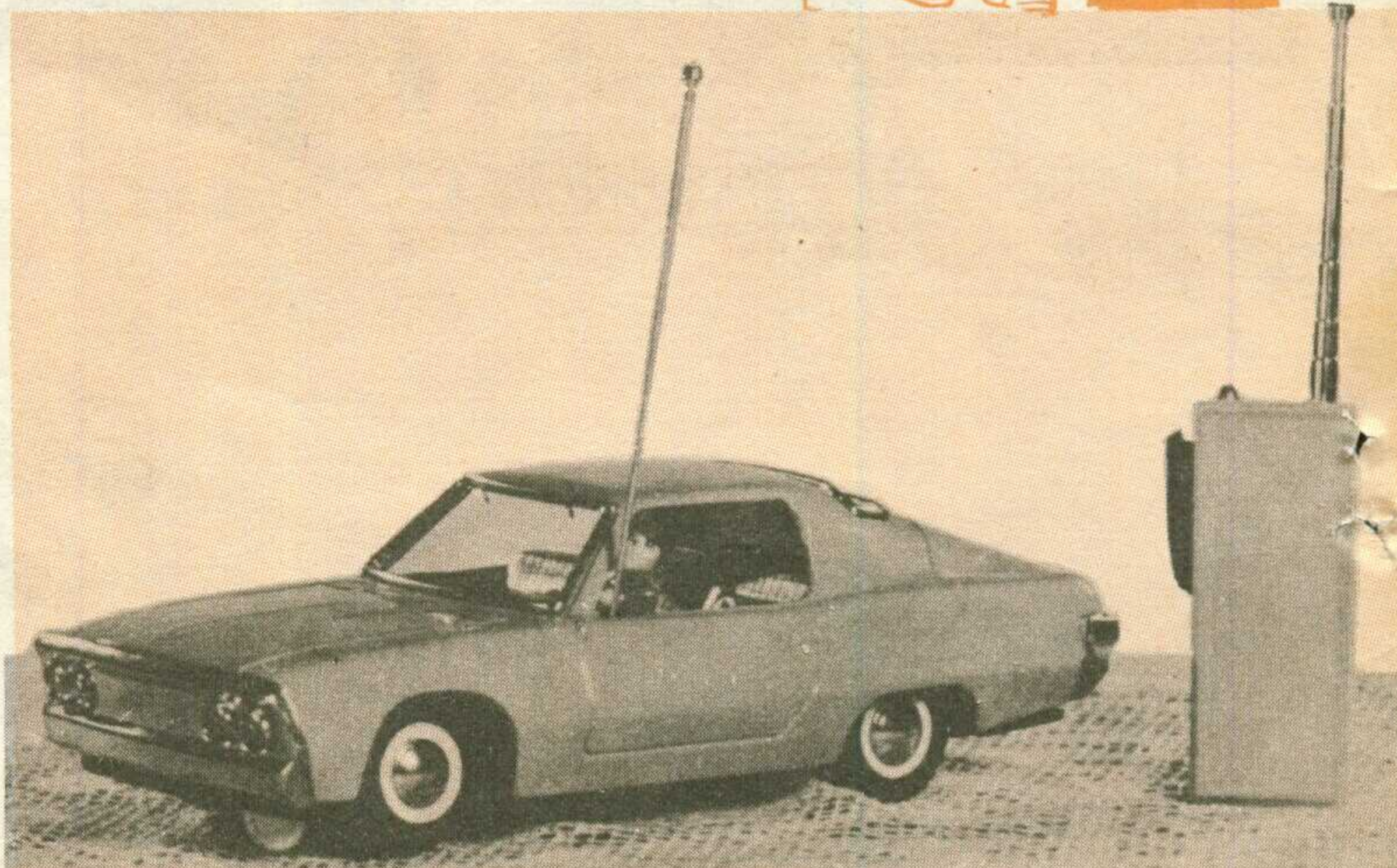
↑ “遥控汽车”利用发射机发出的信号，指挥小汽车自己开动行驶。
