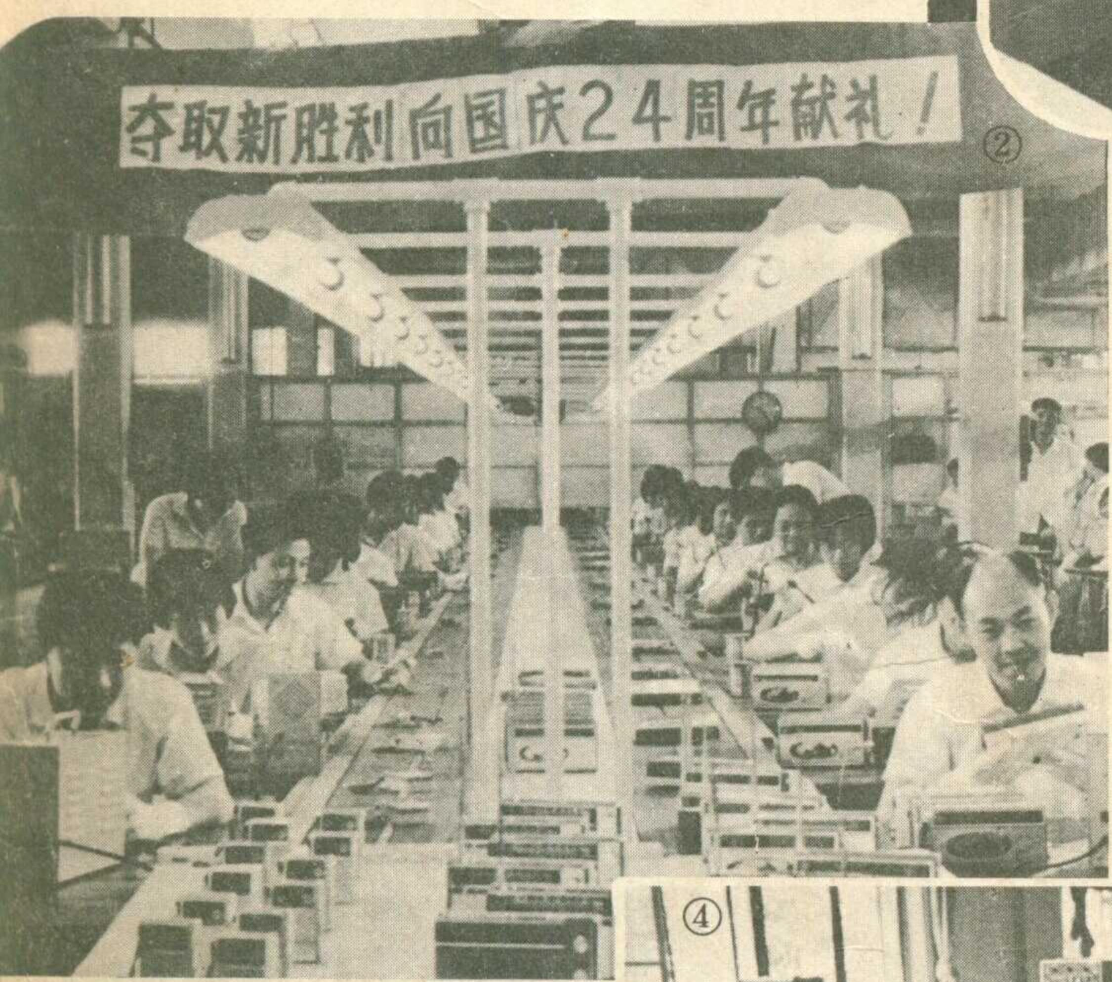
②上海无线电二厂广大职工，大鼓革命干劲，产品的产量和质量不断提高。这是该厂半导体收音机车间的一条流水线。
