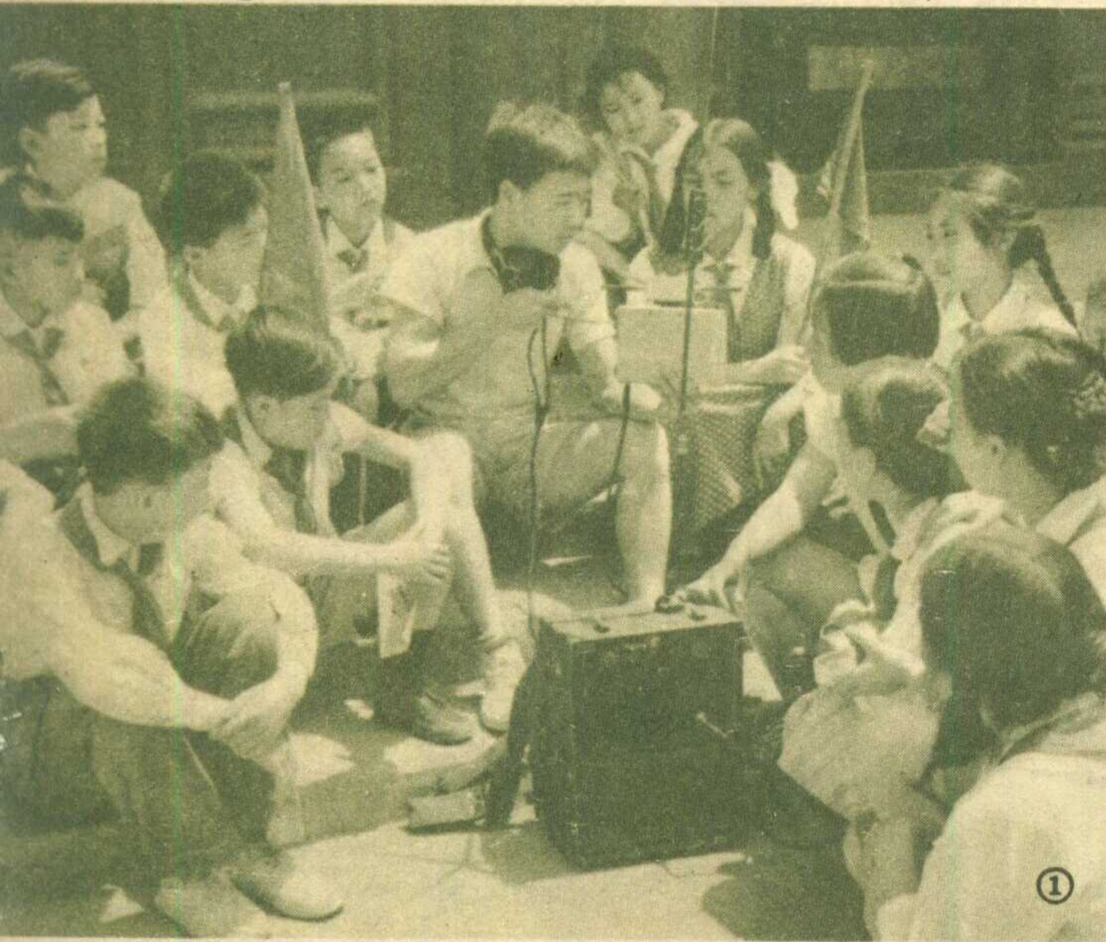
①測向机好象是一双奇妙的“眼睛”，它給我們指出电台隱蔽在哪个方向。
