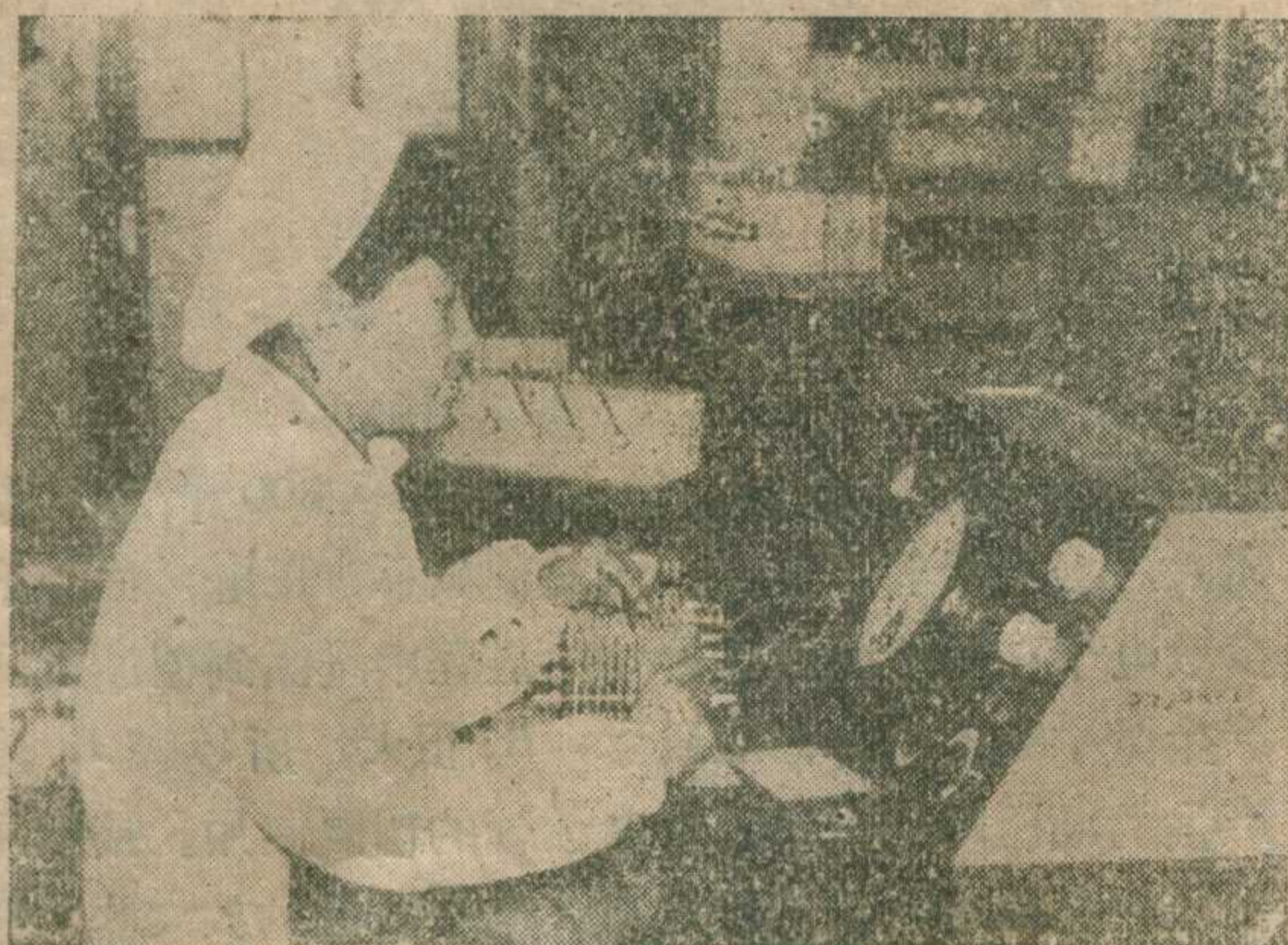
硒整流堆的最后一道工序——成品测试
