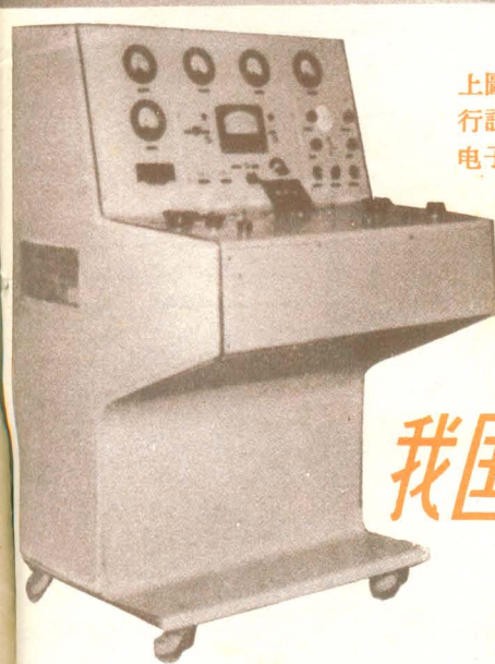
下圖是我國自制的超過英國的百道脈沖分析器，這種儀器能每次分別將100種不同的能量的粒子數目記錄下來。右圖是58型電阻應變儀。
