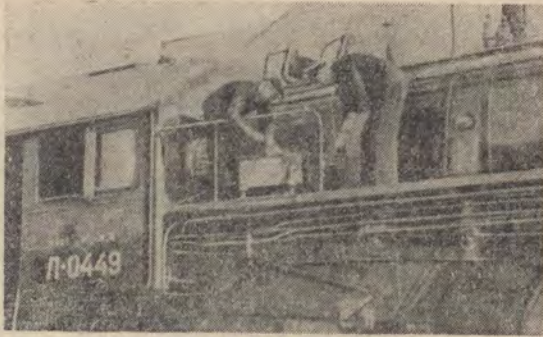
圖6 無線電台設置在機車上的位置
